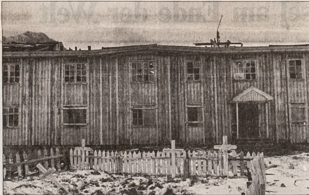
Wohnbaracken und Friedhof der verlassenen Walfangstation Leith Harbour.
